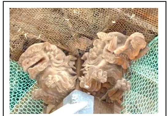
【神明宮拝殿 角の彫り物】
